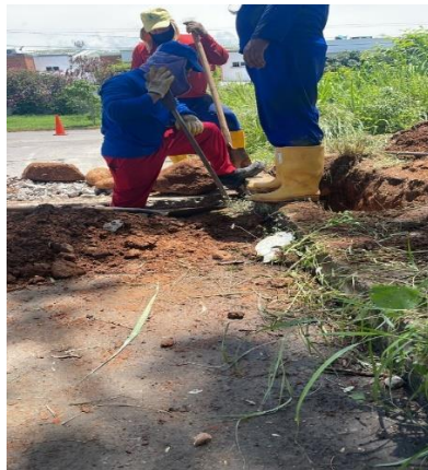
Imagen de empalme de tuberías por optimización del servicio de acueducto Barrio Villalba.
