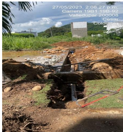
Imagen de empalme de tuberías por optimización del servicio de acueducto Barrio Villalba.
