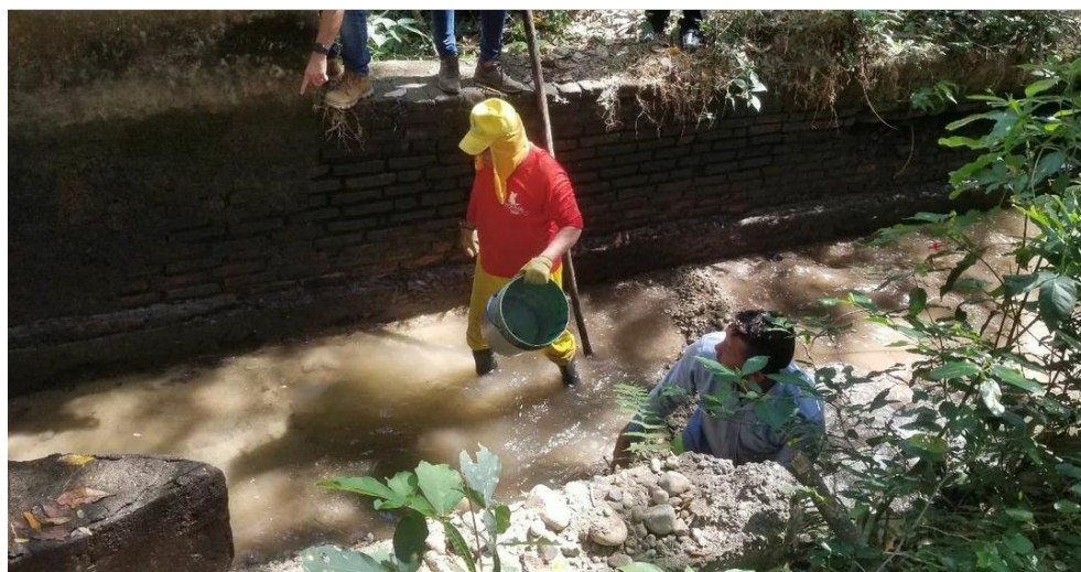
Limpieza canal de aducción en la Planta de Tratamiento de Agua Potable
