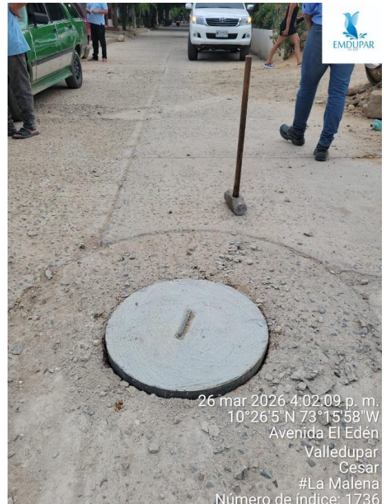
Evidencia reposición de tapa a pozos de inspección.
