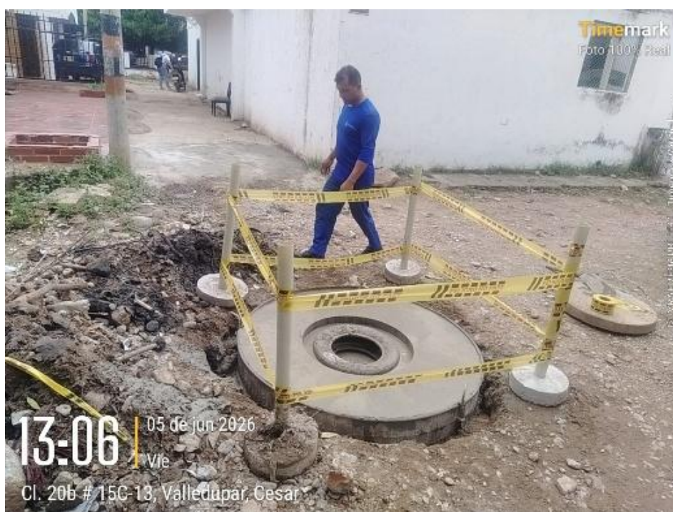
Evidencia de Construcción Placa superior pozo de inspección
