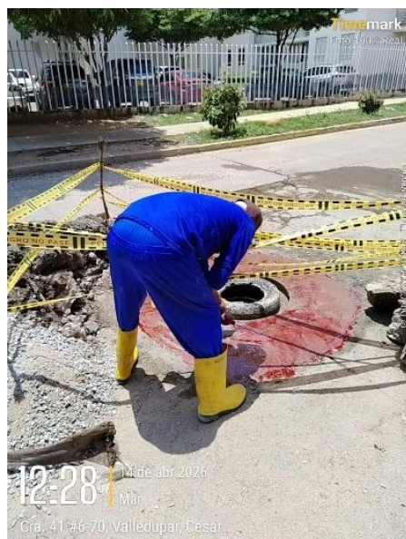
Evidencia de Construcción Placa superior pozo de inspección
