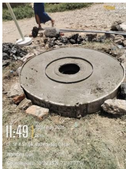
Evidencia de Construcción Placa superior pozo de inspección
