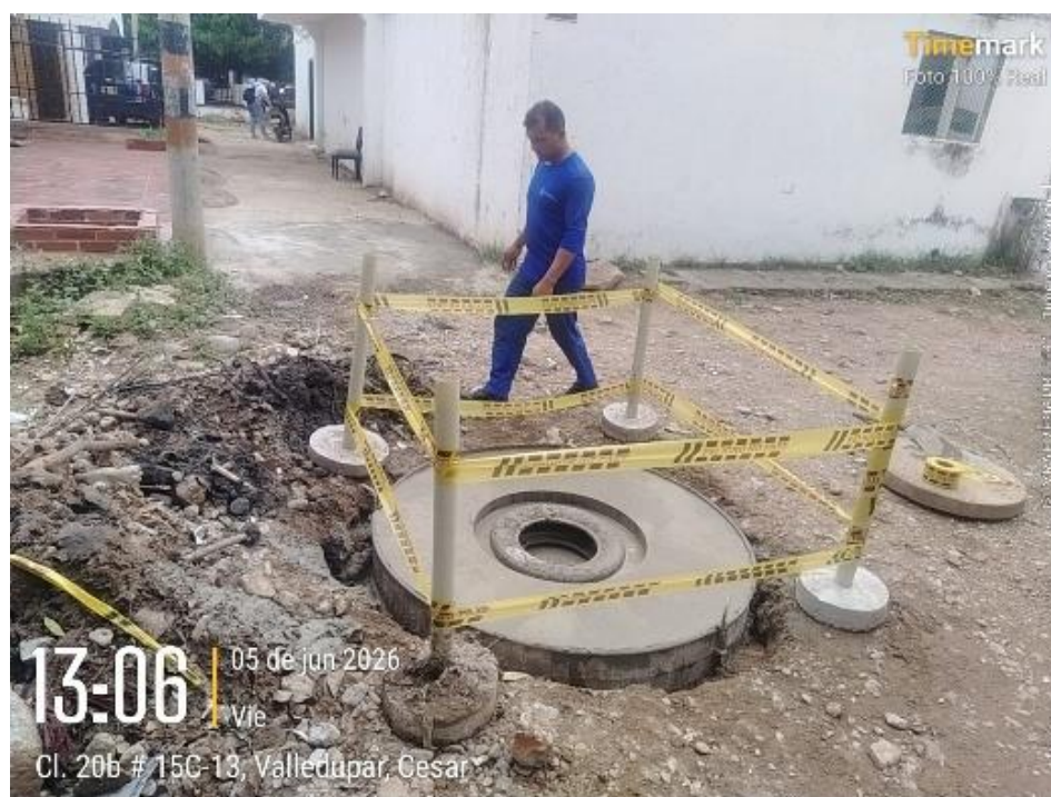
Evidencia de Construcción Placa superior pozo de inspección
