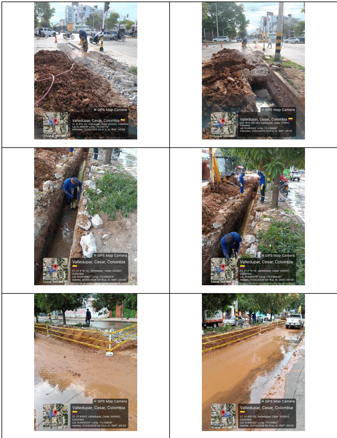
Registro fotográfico intervención de puntos críticos.
